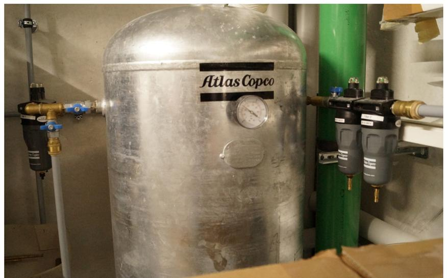
Im Rahmen der Druckluftoptimierung wurde eine Druckluftpauptleitung aufgetrennt und ein Strang direkt aus dem Druckluftkessel versorgt um Druckschwankungen zu reduzieren und dennoch den Erzeugerdruck abzusenken. (Foto: Andramed GmbH)
