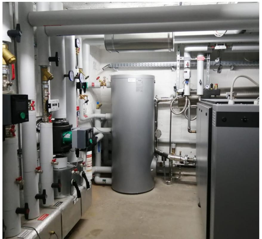
Im Zuge der Heizungserneuerung wurden auch die Pumpen und die Regelung getauscht und ein hydraulischer Abgleich durchgeführt. (Foto: Autohaus Morrkopf)
