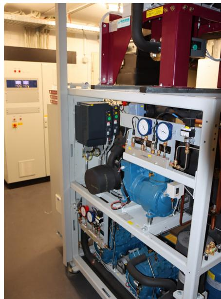
Die Kälteanlage (links) wurde ausgetauscht und die Abwärme der neuen Anlage genutzt. Auch Speicher, Pumpen und die Lüftungsanlage wurden durch hocheffiziente Anlagenteile getauscht. (Fotos: Biomarkt Roland Geist GmbH)
