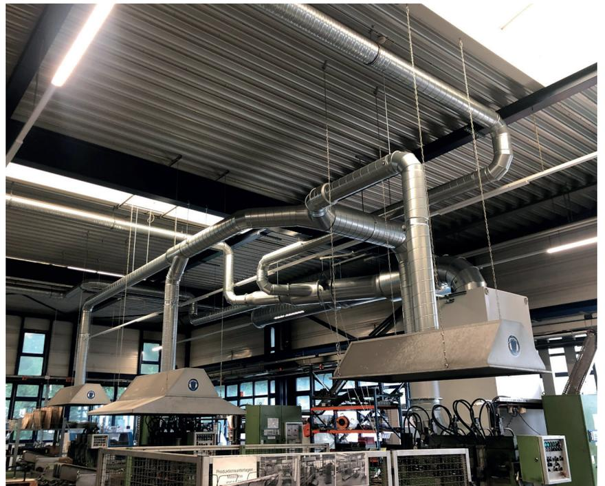
Die Absauganlage wurde mit hochwertiger Filtertechnik ausgestattet und wird bedarfsgerecht betrieben. (Foto: DKF Kloz GmbH)
