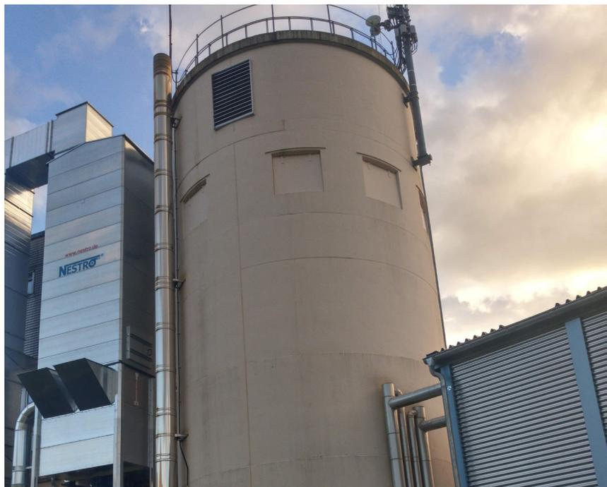
Das Spänesilo wird zur saisonalen Speicherung genutzt. Zukünftig soll auch die Einspeisung von extern mit Hackschnitzeln oder Pellets ermöglicht werden. (Foto: Frank Bürsten GmbH)
