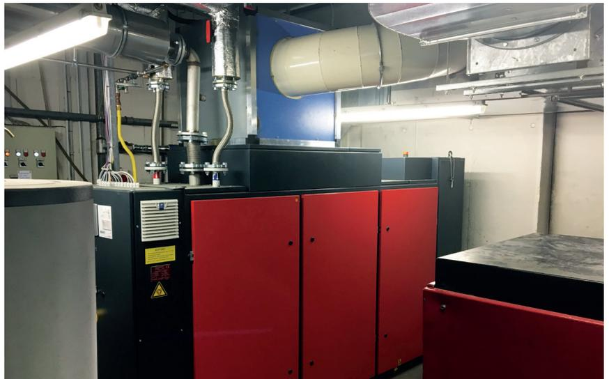
Gasbetriebenes Druckluft-Blockheizkraftwerk (Foto: H. Wennberg Großbuchbinderei GmbH)
