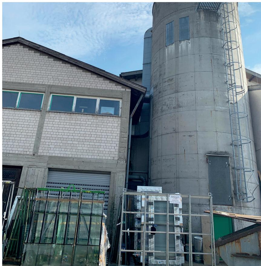
Hofmaier Fenster hat die Beheizung von Öl auf Hackschnitzel umgestellt, die aus Restholz der Produktion gewonnen und im Späneturm zwischengelagert werden. (Foto: Hofmaier Fenster)
