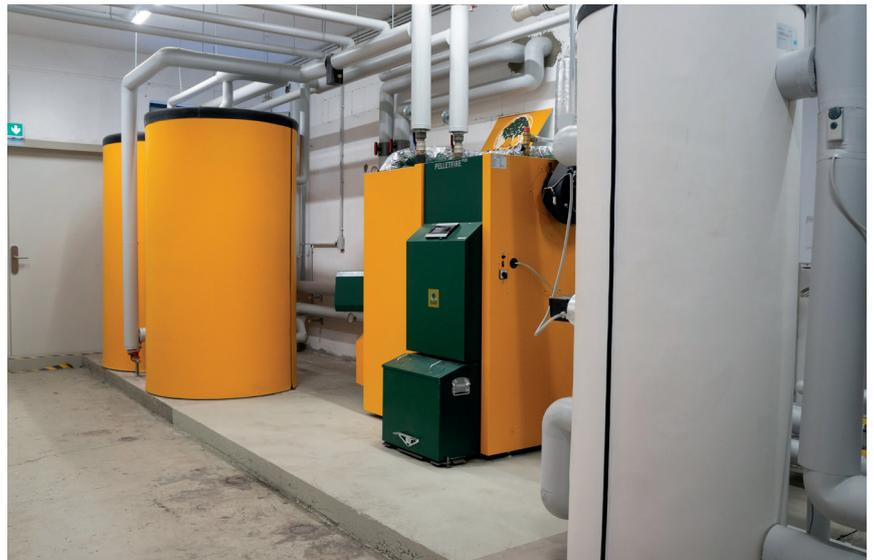
Die Pelletheizung, aufgestellt in der ebenfalls gedämmten Logistikhalle, ersetzt die alte Ölheizung. (Foto: Mader GmbH & Co. KG)
