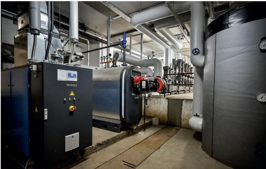
Die alte Heizanlage wurde durch ein BHKW und einen Gasbrennwertkessel ersetzt. (Foto: Naturana Dölker GmbH & Co. KG)
