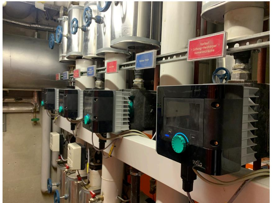
Im ganzen Haus wurden die Pumpen durch Hocheffizienzpumpen ersetzt, die auch mittels intelligenter Steuerungs- und Regelungstechnik betrieben werden. (Foto: Volker Baumann)
