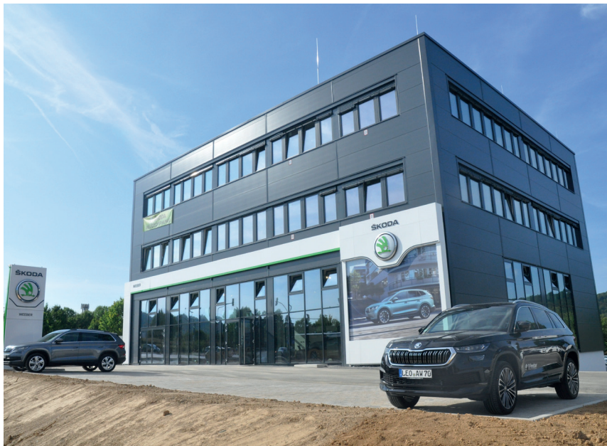
Der Skoda-Neubau in Leonberg setzt komplett auf erneuerbare Energien. (Foto: Neidhard/2022)
