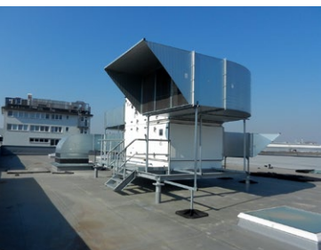
Neues Prüffeld - Dachaufsicht
