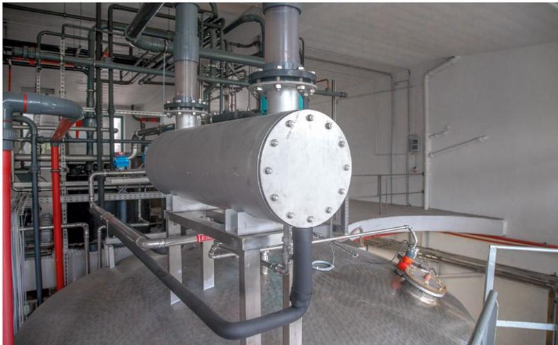
Kondensatorinstallation auf dem Acetatordach
