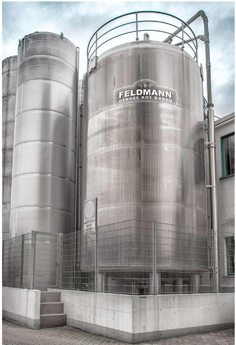
Acetator für die Essiggärung mit einem Füllvolumen von 90.000 Litern
