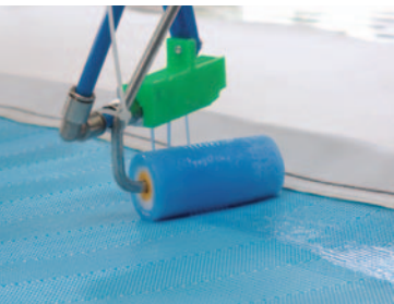
Detailaufnahme: Auftragen der Streichmasse
