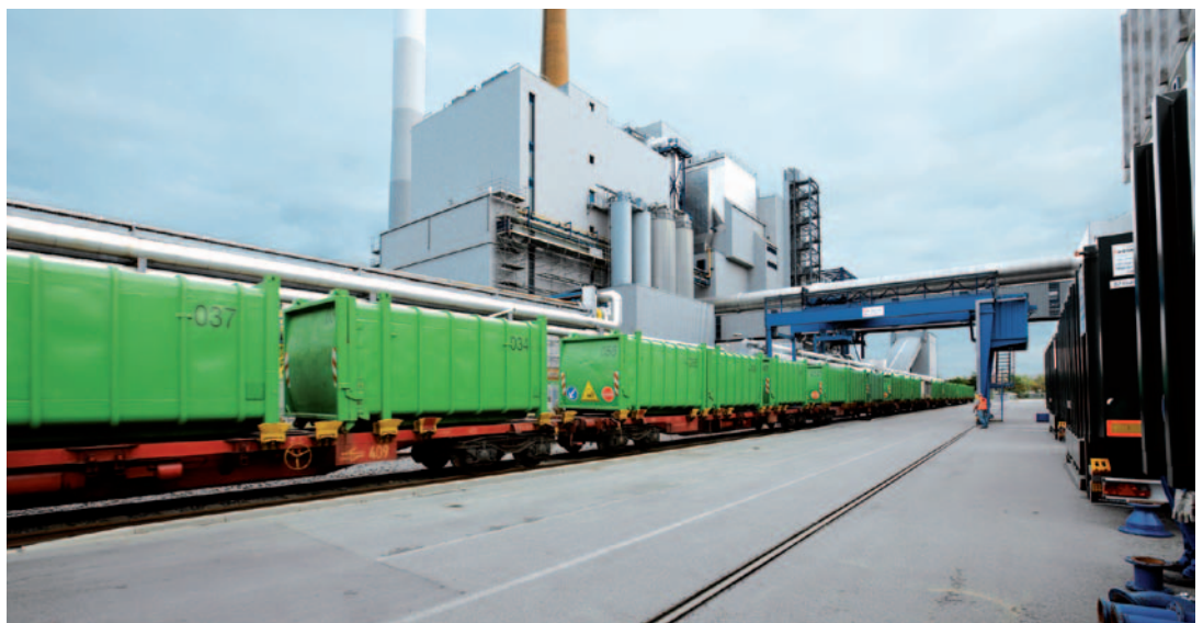
Abfallanlieferung per Zug
