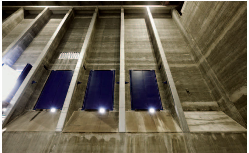
Durch die Bunkertüren wird der Brennstoff von Lkw in den Bunker gekippt.
