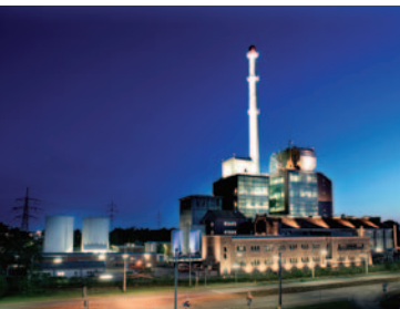
Heizkraftwerk West der Stadtwerke mit Fernwärmezentrale
