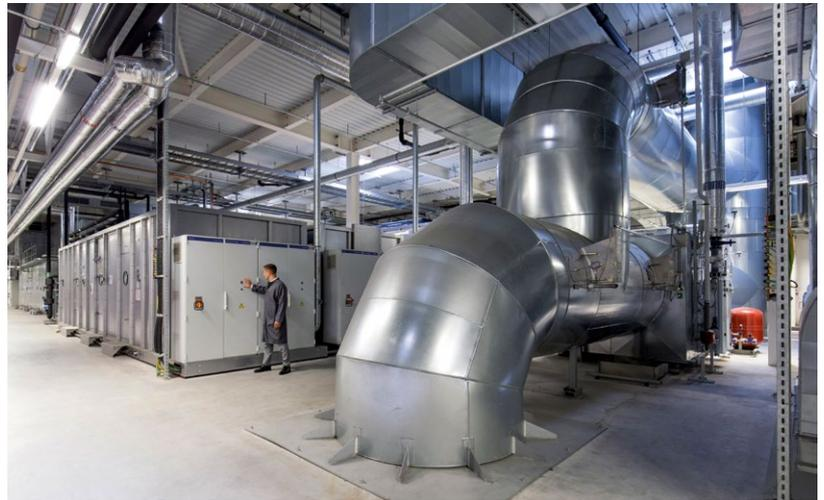
Abluftrohre als Teil der neuen Nass-Chemischen Reinigungsanlage
