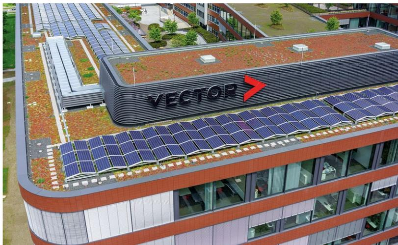
532 Photovoltaikmodule können über 98 MWh/Jahr erzeugen
