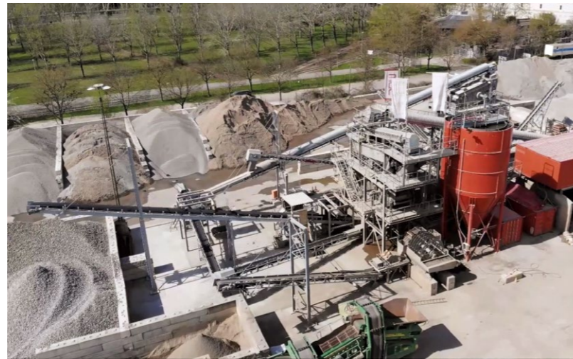
Gleisschotterwaschanlage RUZ Mineralik GmbH
