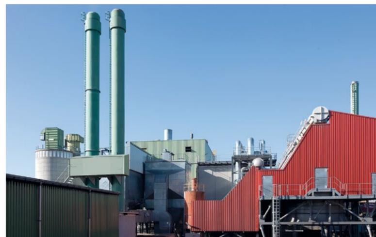
Biomassekraftwerk mit Wärmetauscher in der Abdampfleitung
